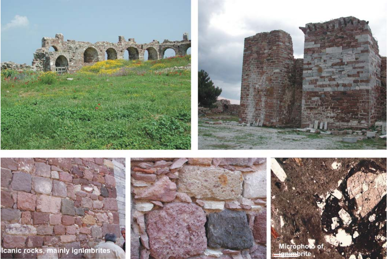
Φωτ.4 Πίνακας φωτογραφιών από τη μελέτη των δομικών λίθων του κάστρου της Μυτιλήνης
